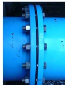
バルブ等のフランジ接合箇所が海水に浸漬する箇所のため、チタンの高耐食性が評価されチタン製ボルト・ナットが使用されました。
